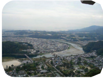
岩国城天守閣から望む錦川・錦帯橋
